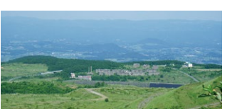
④ 松尾鉱山跡地
